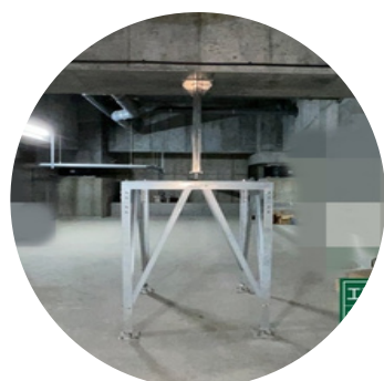
天井アンカー付け
